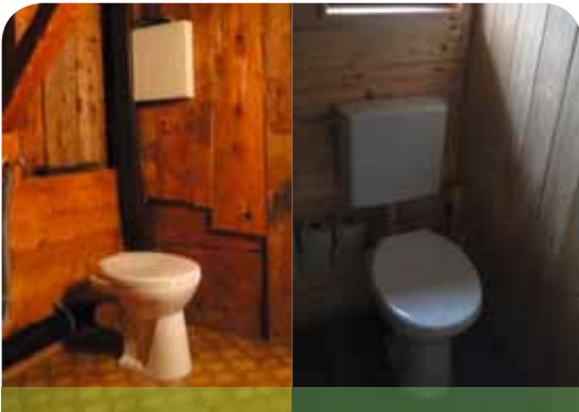
Dachgeschoss-WC: Aus Alt... ...mach Neu
